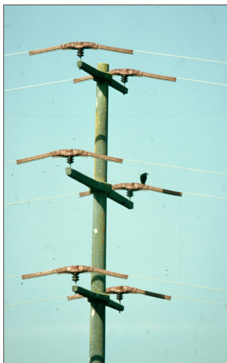
”Mördar-stolpe” som är åtgärdad med 130 cm långa isolatorhöljen. Foto: Dieter Haas.
